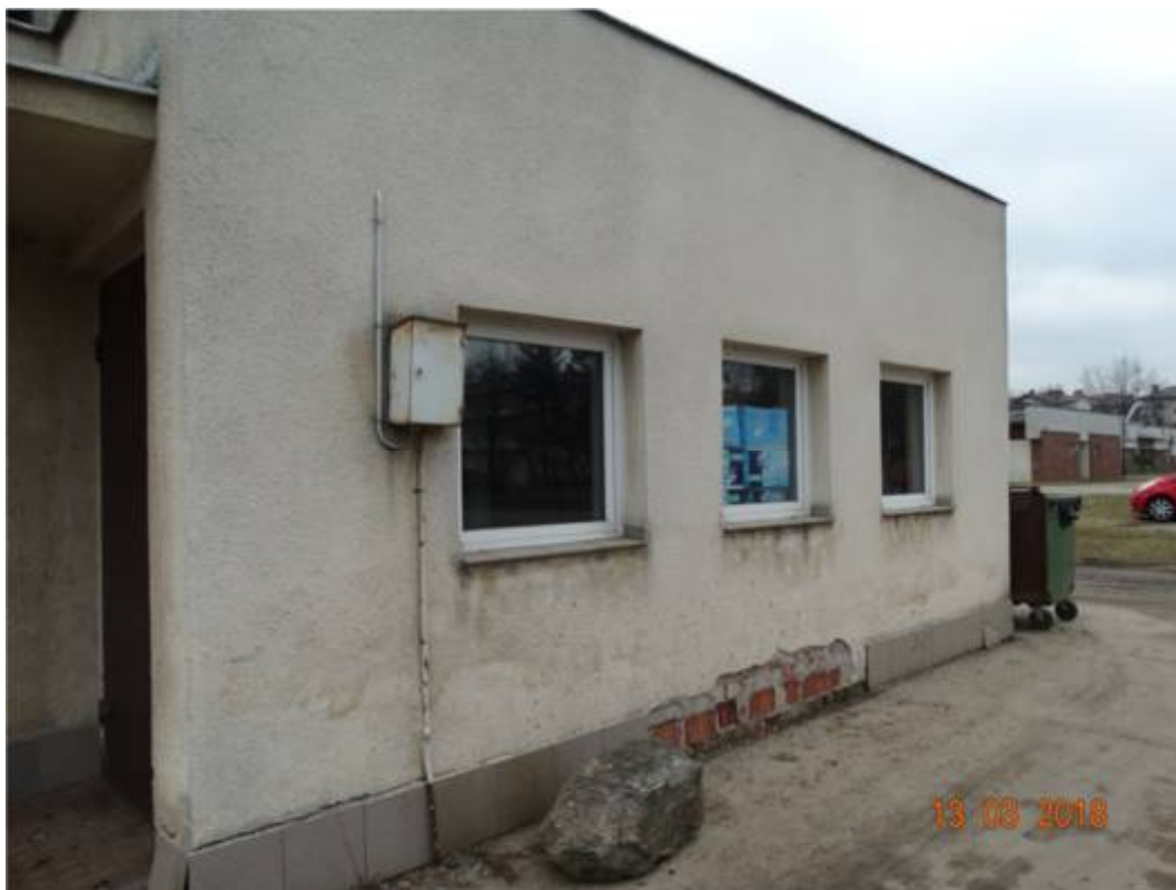
Fot. nr 3 Widok fragmentu elewacji północnej- uszkodzenia cokołu.
